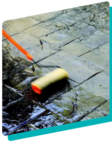
PROTECCIÓN Y REPARACIÓN
