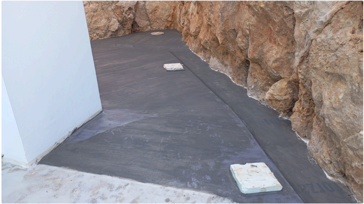
Membrana líquida vista aplicada sobre el soporte existente, adaptada al encuentro con la roca sin piezas prefabricadas.
