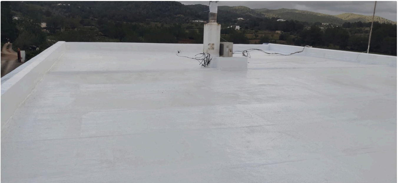
Azotea rehabilitada sobre la lámina asfáltica existente, sin demolición: membrana líquida con acabado claro reflectante.
